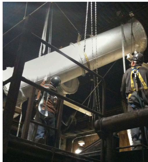
高热风管安装
